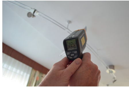
Die Temperatur-Messung der Decke im Arbeitszimmer, wo die elektrischen Infrarot-Folienheizung installiert wurde, zeigt (an einem Dezember-Tag) 22,5° C.
