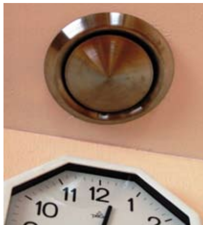
Nach der Sanierung sieht man nur noch die Lüftungsauslässe der Wohnraumlüftungsanlage.
