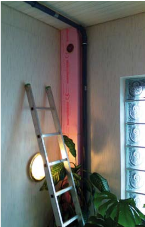
Alfred Lang benötigte auch rechteckige Lüftungsleitungen und baute diese aus Dämmplatten in Eigenregie – ideal, denn so werden auch Geräusche gedämmt.
