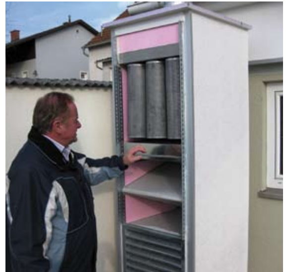
„Airtower“ (Luftturm) nennt Alfred Lang die im Garten aufgestellte und von ihm selbst konstruierte Box, in der die verschiedenen Filterstufen (inkl. Aktivkohle) untergebracht sind.
