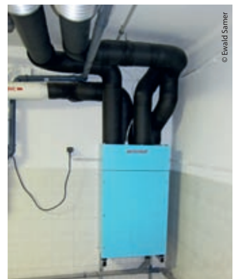
Frischlufte ohne Zug, dank neuer Lüftungsanlage
