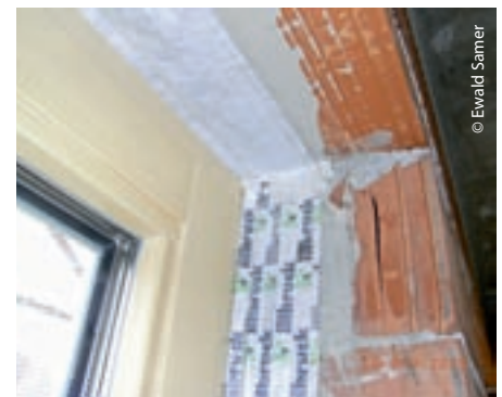
Kältebrücken durch Abdichten vermeiden
