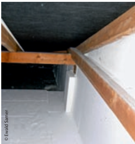
Wichtig: auch die Wand am Dachboden musste gedämmt werden
